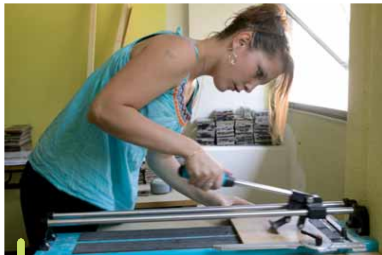
Le chantier d'insertion permet de bâtir un nouveau projet professionnel dans des conditions proches de celle de l'entreprise.
